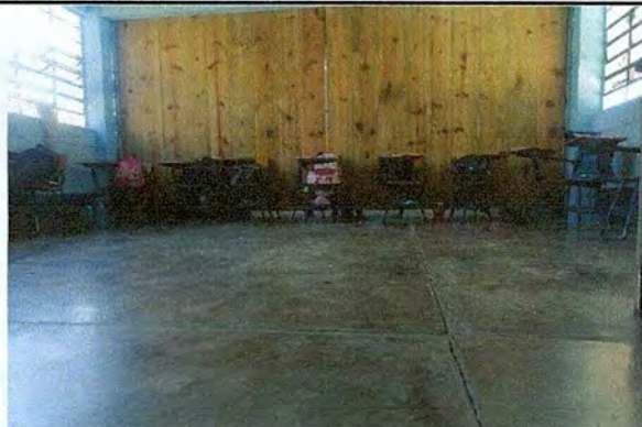
Foto 1: Mejoramiento de piso de aula polifuncional
